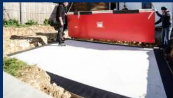
Pose du premier panneau
