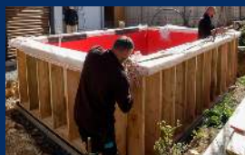
Pose du quatrième panneau
