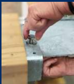
Pose des platines d'angles Répéter l'opération à chaque pose de panneau
