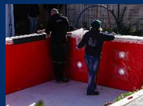
Pose du troisième panneau
