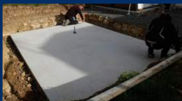
Vous préparez la dalle béton
