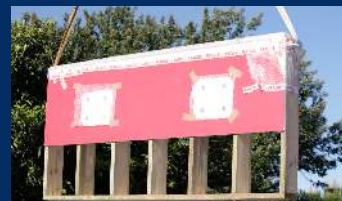
Pose du second panneau
